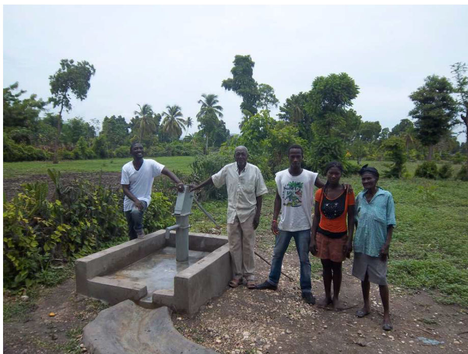
Mise en place d'infrastructures de distribution d'eau
